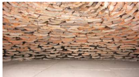
Interior de la bóveda de un horno a base de tejas en Ziga
