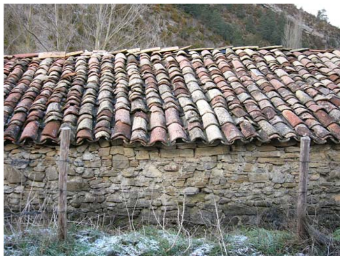
Vista parcial de cubierta con teja propia de tejería
