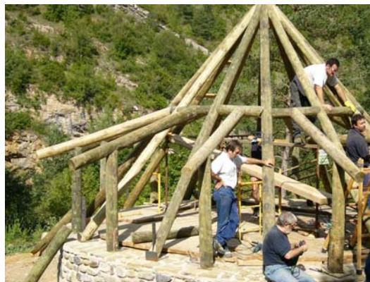
Voluntarios en los trabajos de reconstrucción de la nivera
